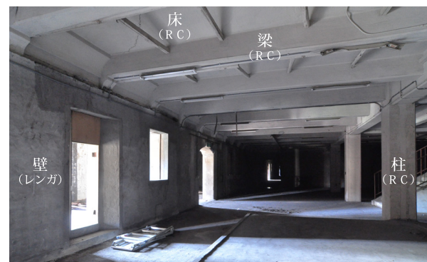
旧被服支廠倉庫の1階。壁はレンガで柱・梁・床はRC。従来の技術であるレンガ造をベースに、RCを組み合わせているように思える。
