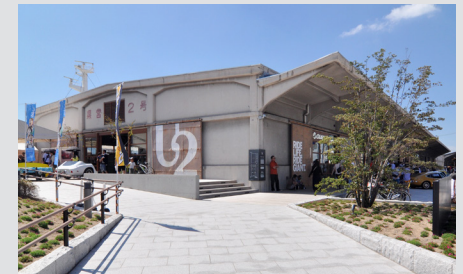
旧被服支廠と同じく広島県が管理する古い倉庫を、サイクリスト向けホテルや店舗へ再生（尾道市）
