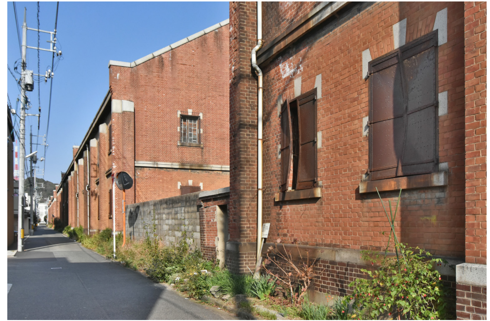
爆風で曲がったという窓の鉄扉。何らの解説書きがなくても、その存在は被爆の実態を雄弁に語ってくれる。
