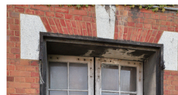
小さな開口部は水平アーチとなっている。
