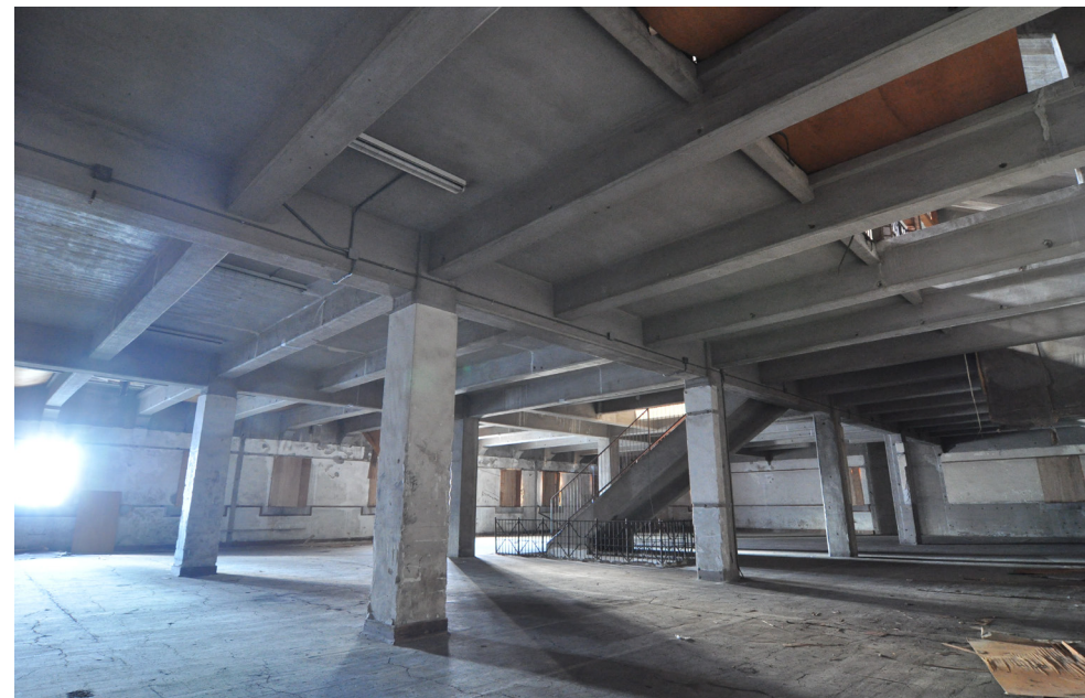
旧被服支廠倉庫2号棟2階の様子。RCの柱・梁の様子が分かる。3階との間には一部吹き抜けが設けられている。
