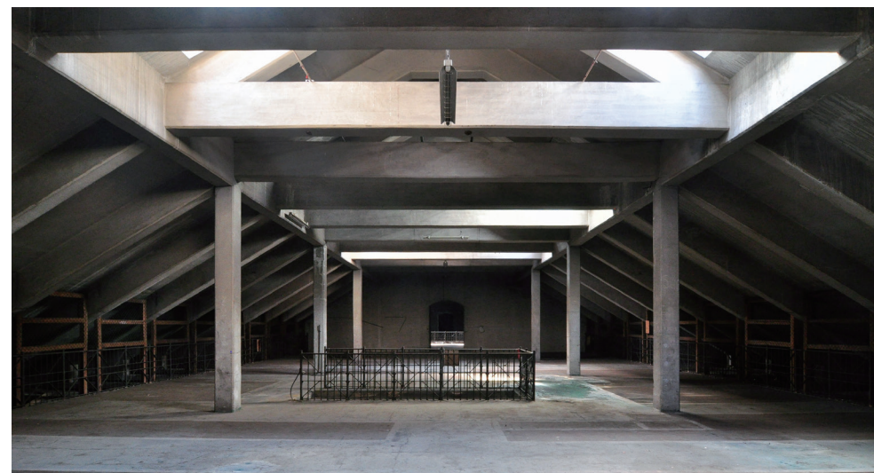
旧被服支廠倉庫3階の小屋組。屋根板も含めて全てRCで作られている。独特な空間に天窓の光が差し込む。
