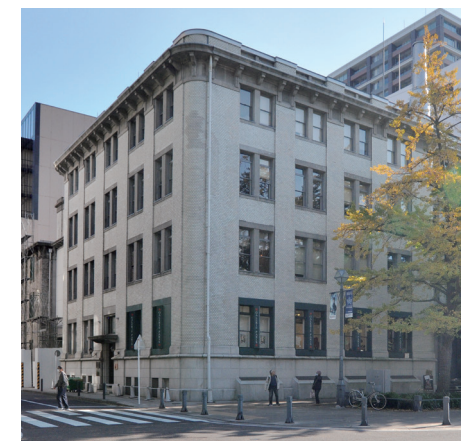
旧三井物産横浜支店は国内現存最古のRC造オフィス
