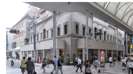
関東大震災後のRC造（旧三井銀行広島支店）
