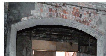
開口部はレンガのアーチになっている。
