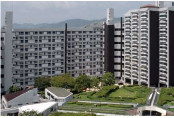
1 市営基町高層アパート Motomachi Apartment Complex
