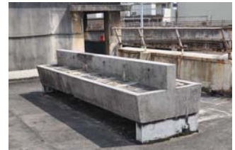
屋上の洗い場
